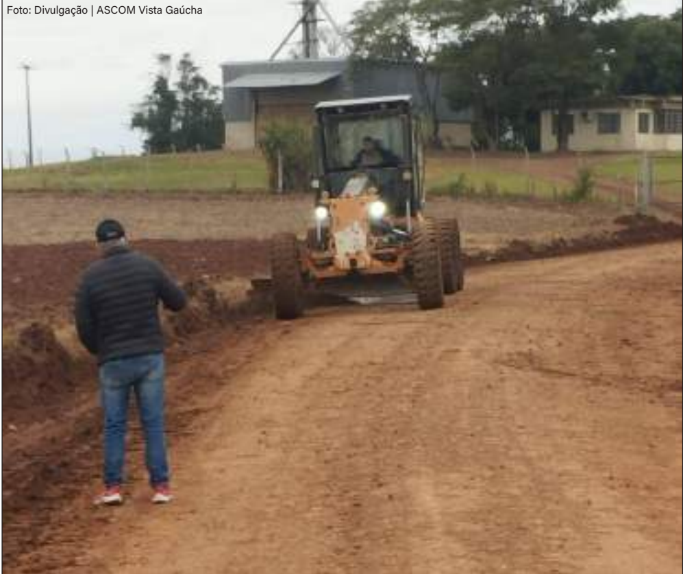
Foto: Divulgação | ASCOM Vista Gaúcha Com a base finalizada, a aplicação da última camada de asfalto está prevista para os próximos dias
