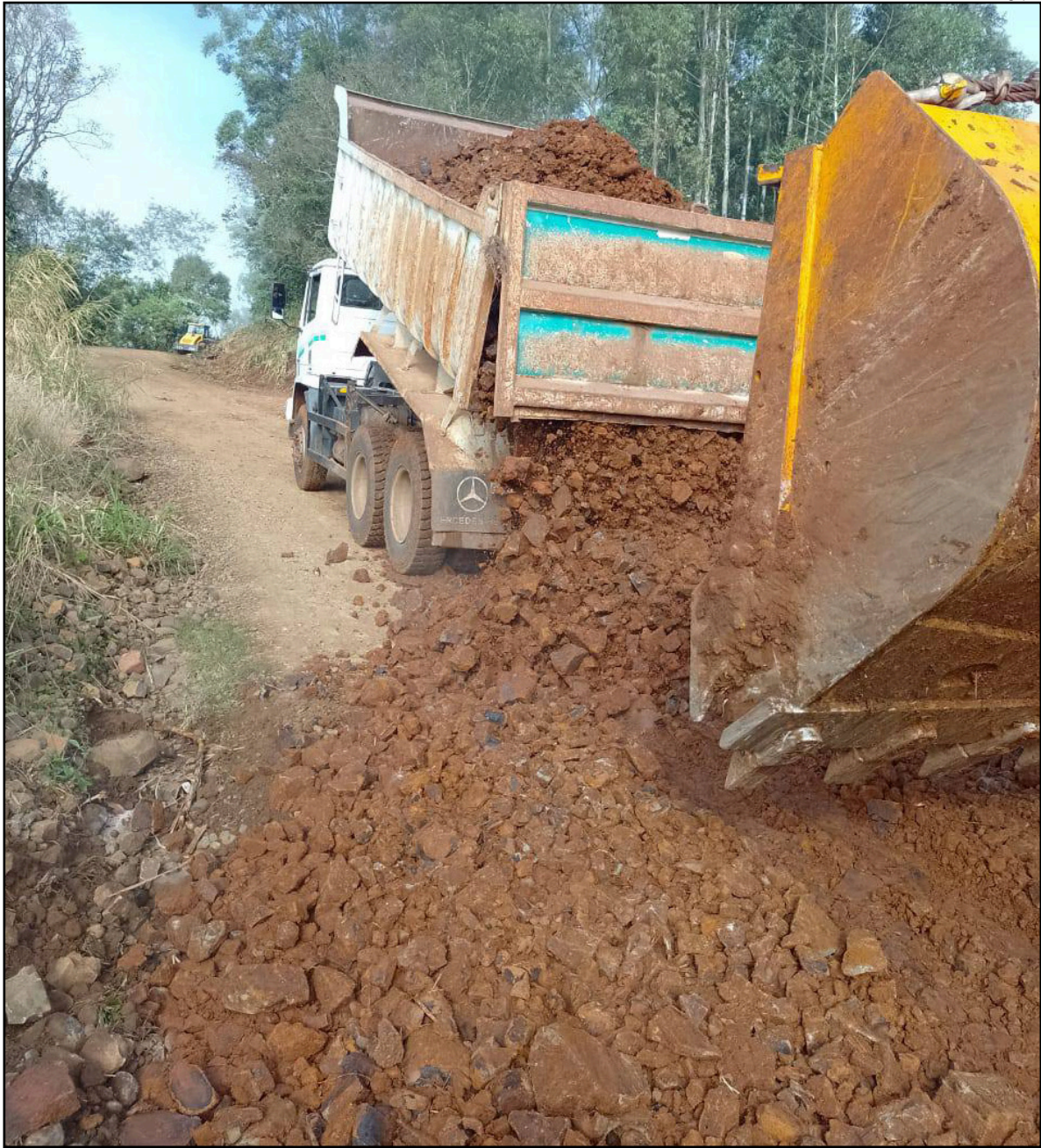
Trabalhos seguem intensos nas ruas do interior
