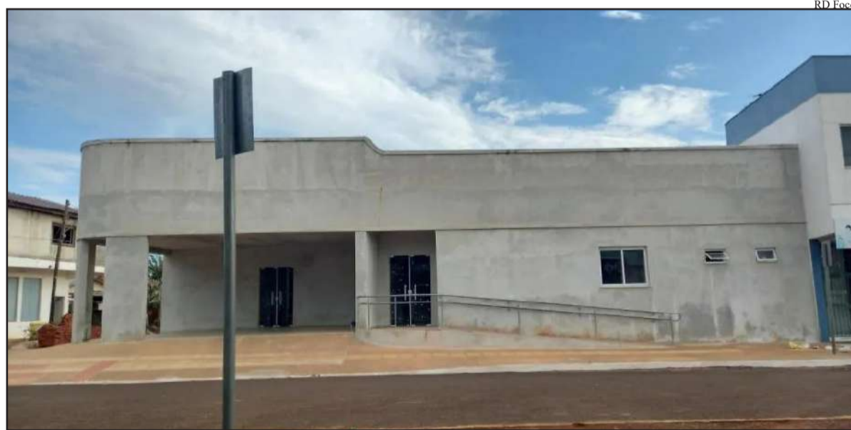
Prédio do Hospital de Redentora foi completamente reformado
