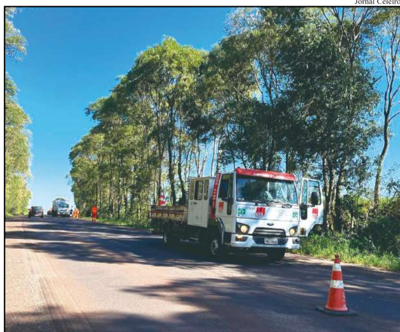
Os trabalhos estão em andamento
