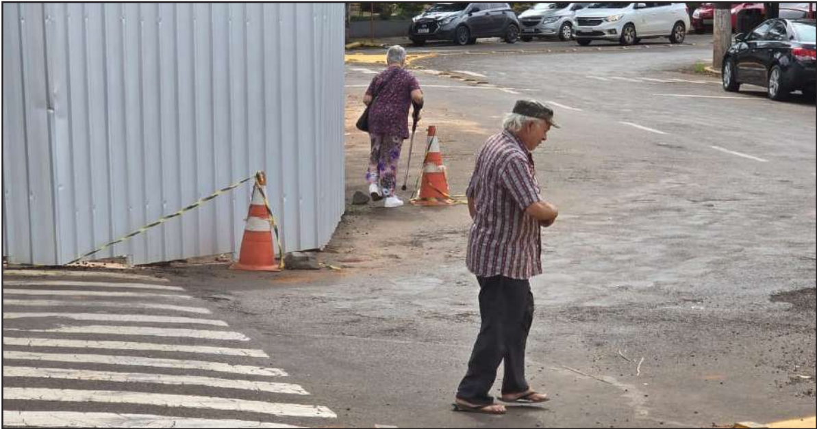
Sem o passeio público, pedestres precisam caminhar na rua, aumentando o risco de acidentes
