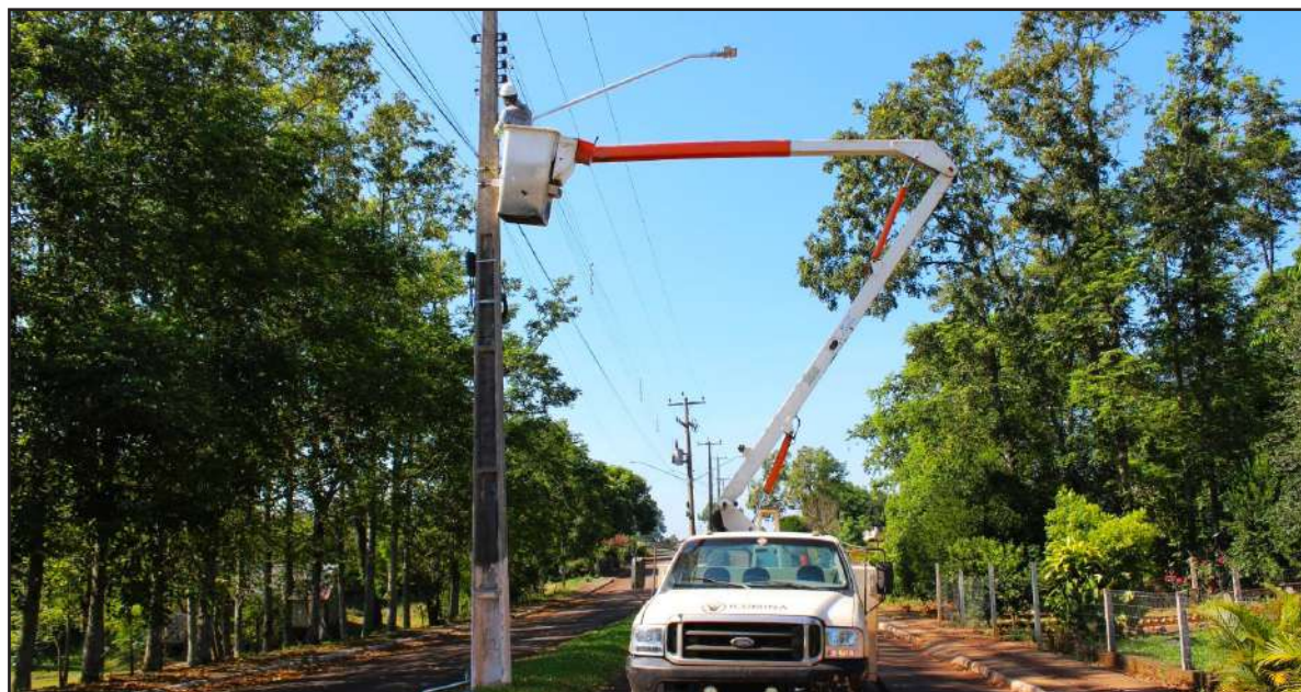
Operário fazendo a troca de lâmpadas no interior de município
