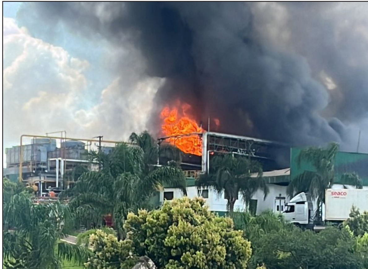
Incêndio destruiu grande parte do Frigorífico Mais Frango
