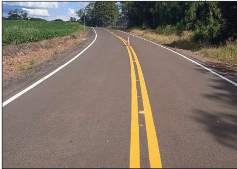
Pintura e sinalização já está concluída
