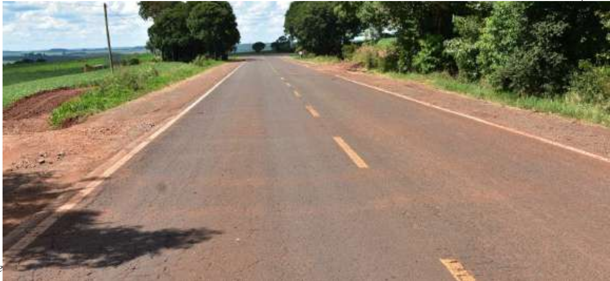
O investimento da obra será de quase meio milhão de reais.
