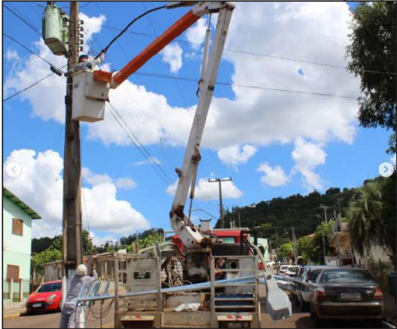
Equipes trabalhando no município de Vista Gaúcha
