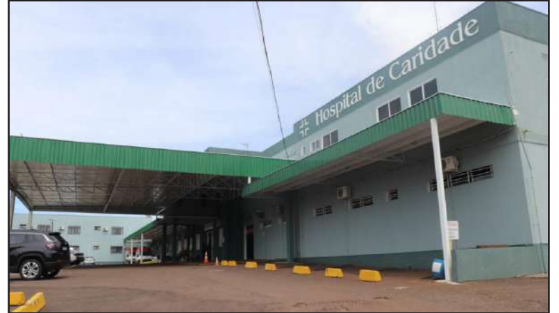
Estão em andamento obras importantes na entidade
