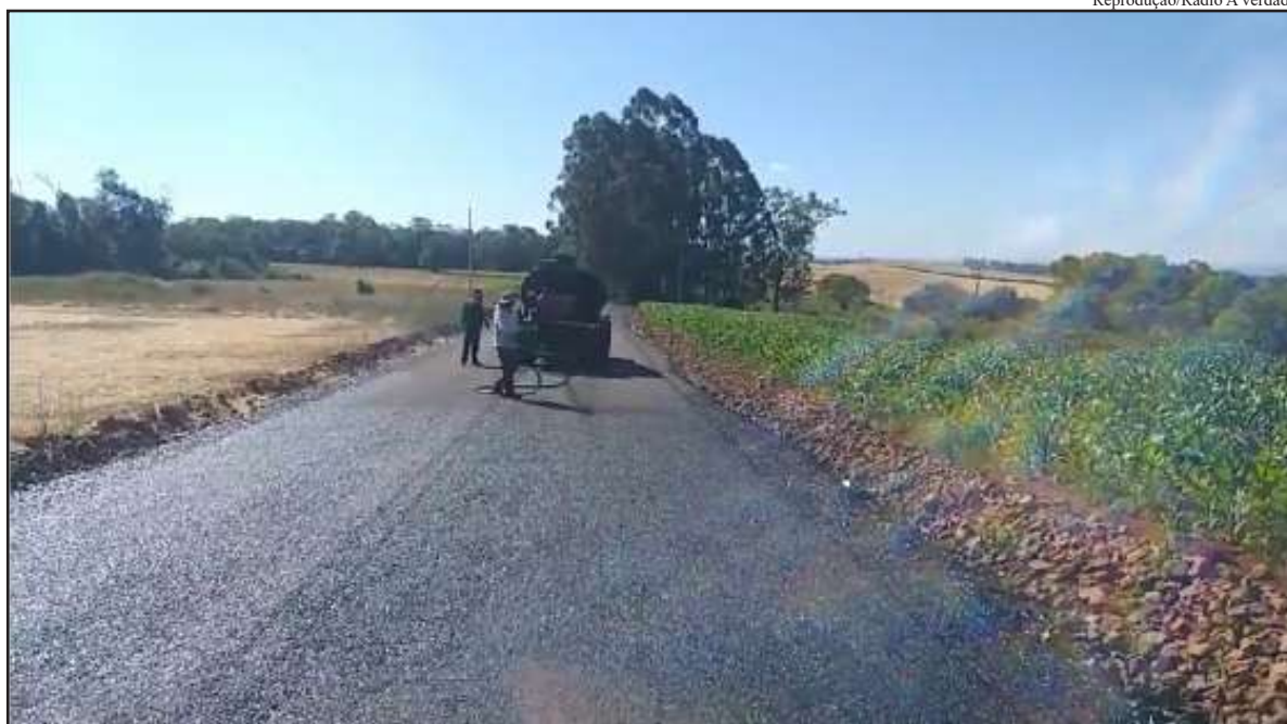
A primeira parte do asfaltamento está pronto. A conclusão total da obra está prevista para o final do ano
