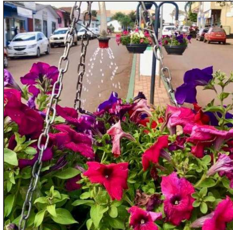
Sistema de irrigação das floreiras instaladas nos canteiros centrais da Avenida Presidente Vargas
