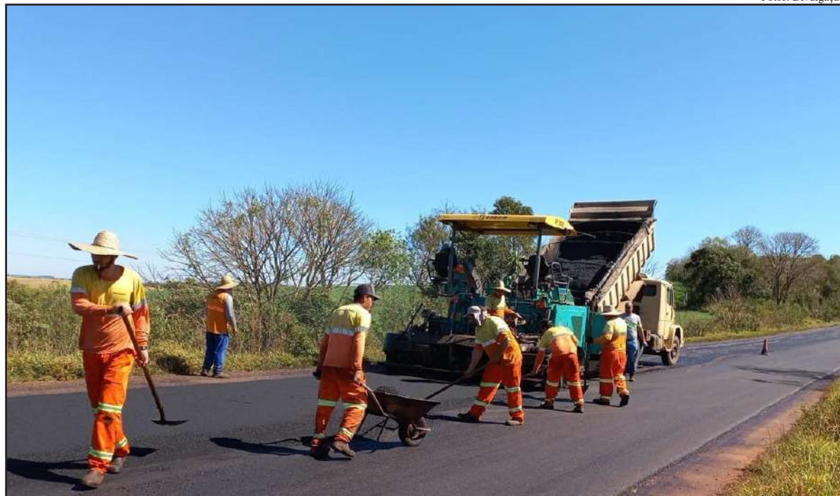
Daer confirma que os primeiros 10 quilômetros da obra foram concluídos
