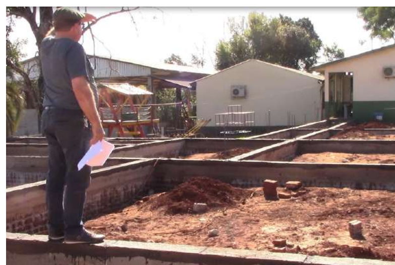
Prefeito Nilson observa as obras na Escola Maria Belmont Albert
