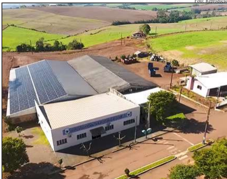
Placas de captação estão instaladas em telhados de prédios públicos
