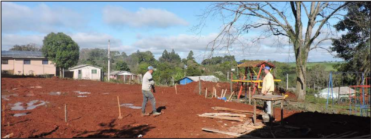
As obras já estão em andamento junto ao pátio da escola
