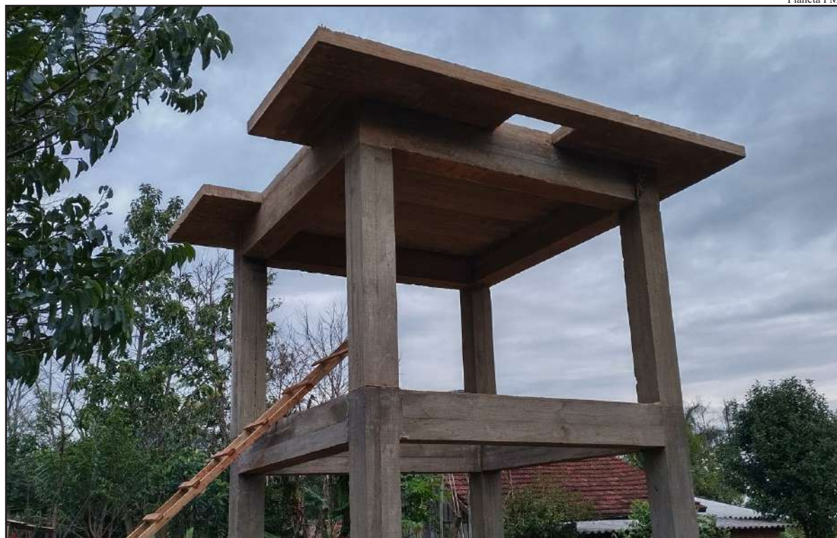
Base está pronta para receber reservatório de água
