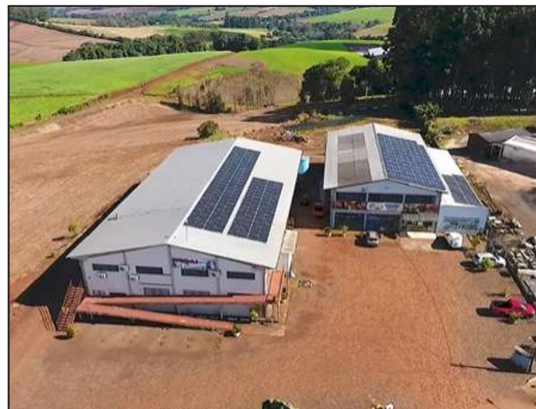
As placas vão gerar energia suficiente para abastecer os prédios públicos
