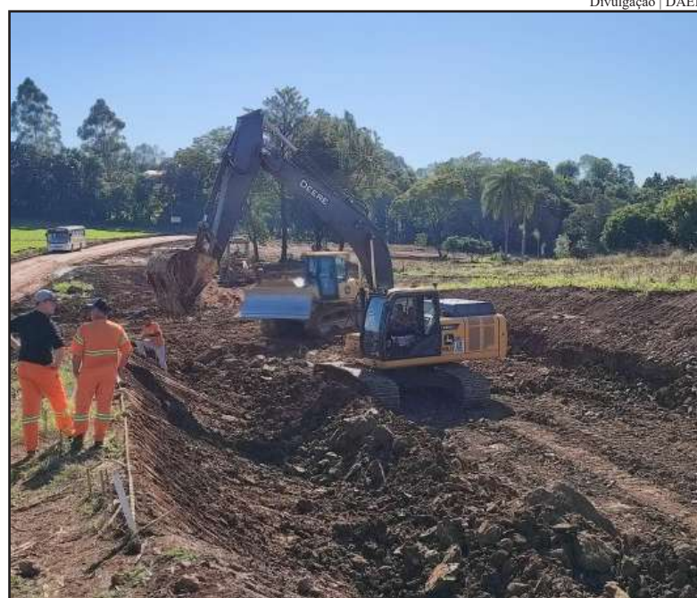
Trabalhos executados por equipes do DAER concentram-se em terraplanagens e drenagens
