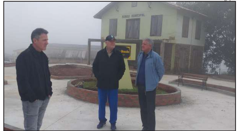
Nilton Arno Braucks e Locatelli acompanham as obras na praça
