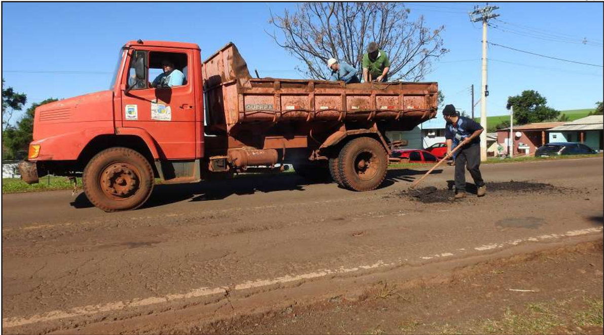
A medida consistiu no fechamento de inúmeros buracos e correção de algumas imperfeições, utilizando emulsão asfáltica
