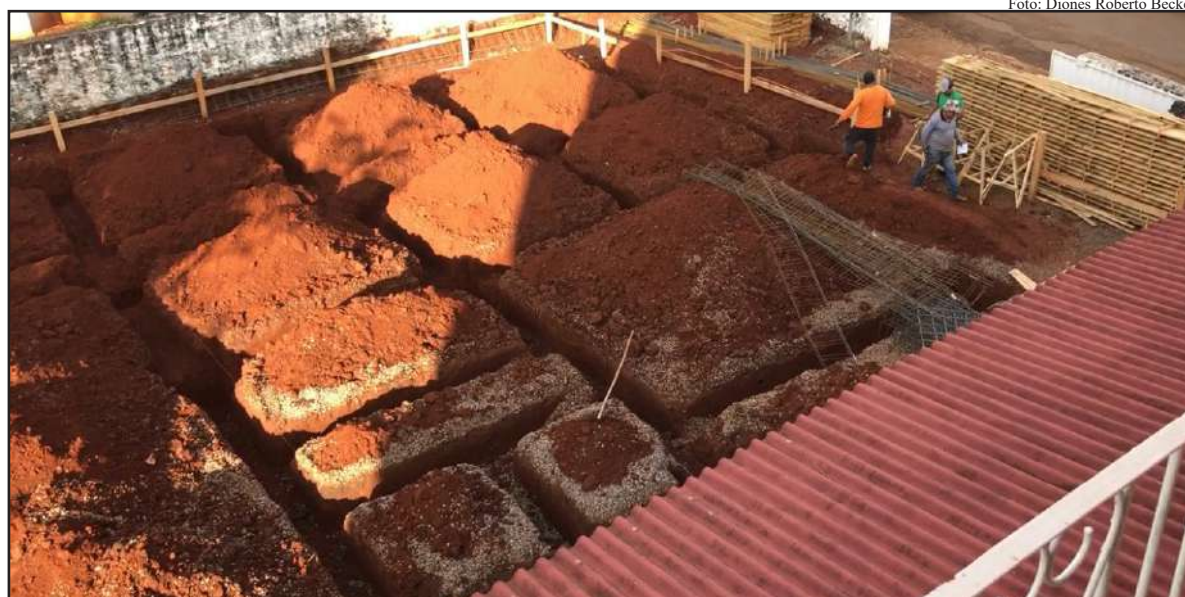
Atualmente, os funcionários da empresa trabalham nas fundações do novo prédio
