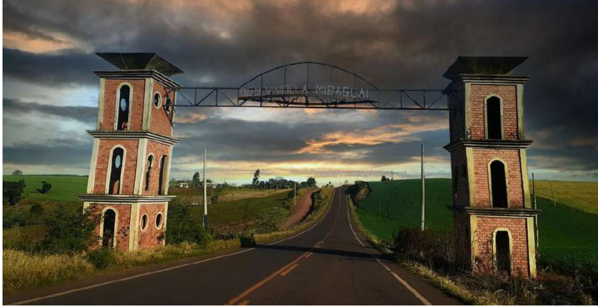
Trecho que sai de Redentora, passa por Miraguai e vai até Tenente Portela vai receber obras
