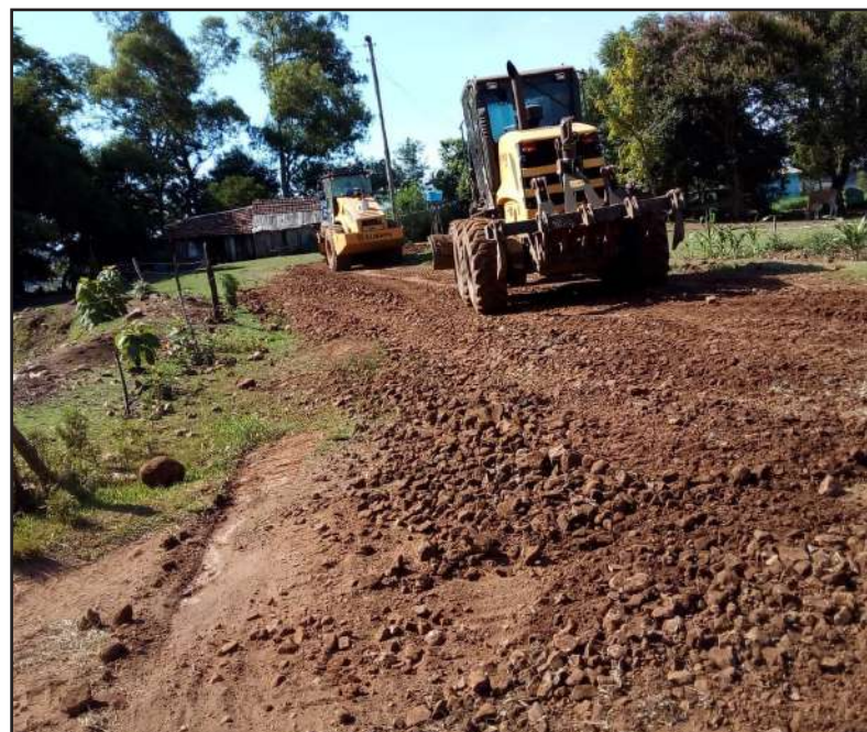
Trabalhos estão sendo realizados pelo interior do município
