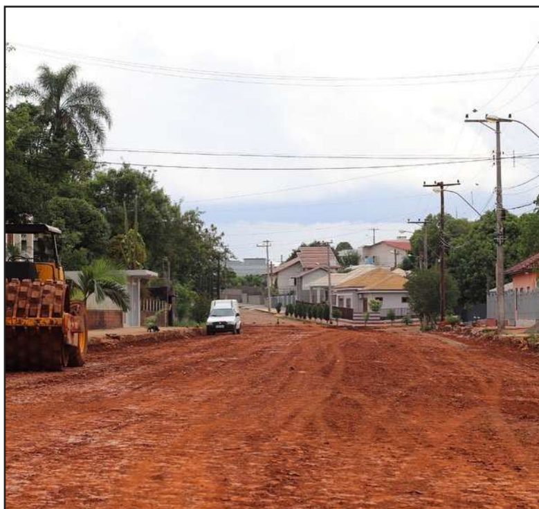
Serão 10 mil metros de pavimentação
