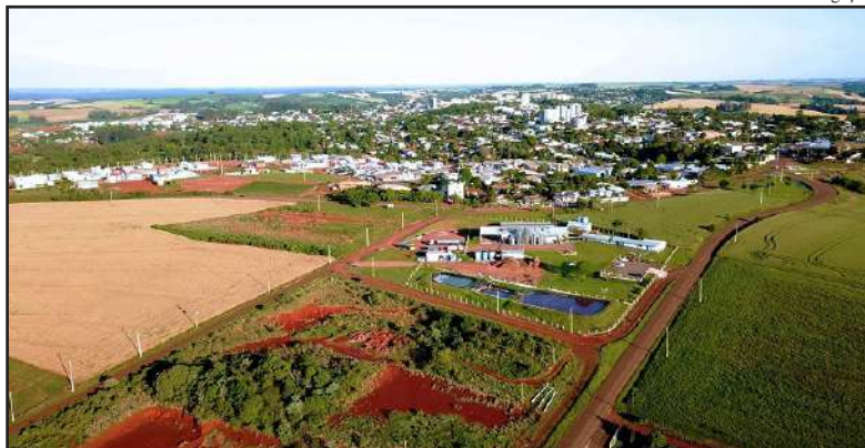
Parque Industrial Osvaldo Trentin está localizado às margens das rodovias 472 e 330
