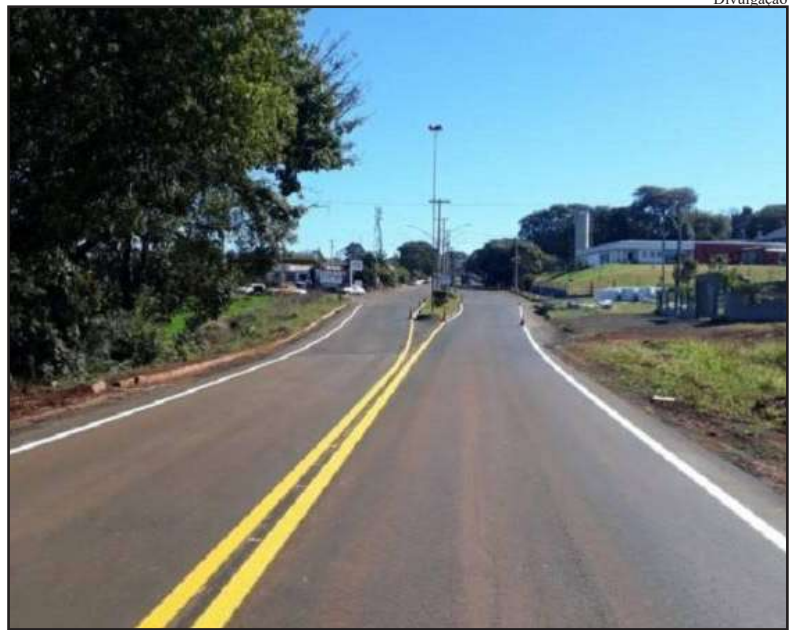
R$ 5 milhões foram utilizados na obra
