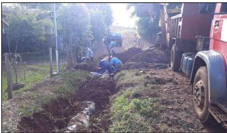
Obras ocorreram no Bairro Braga em Miraguaí
